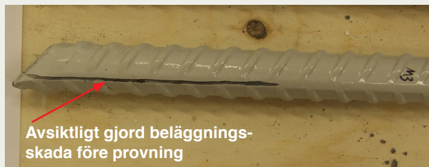
Figur 4. Exempel på en epoxibelagd varmförzinkad bergbult med en avsiktligt gjord beläggningsskada ned till stålyta som exponerats två år i Muskötunnelns bergvägg.
